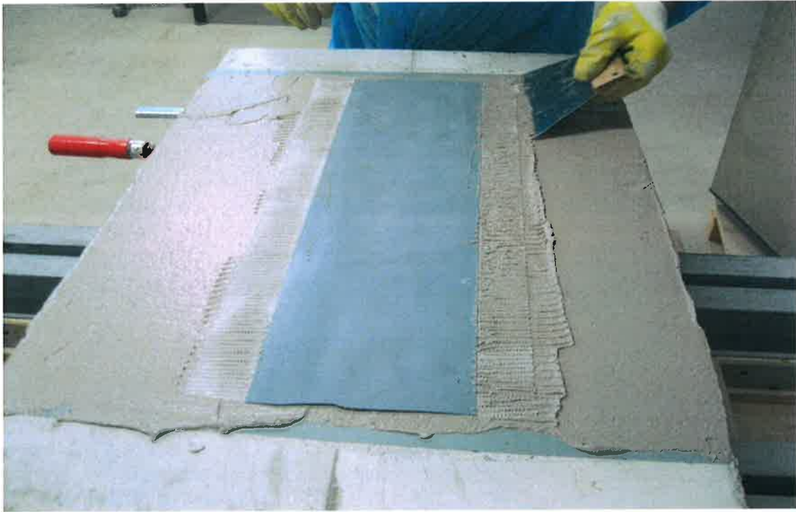
Bild A3: 1. Beschichtung mit WFP IQ Hybrid 2K und einarbeiten WFP Dichtband
