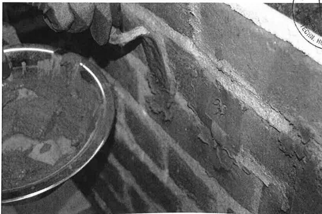
Bild B4: Verschließen der Injektionslöcher mit Schnellzement
