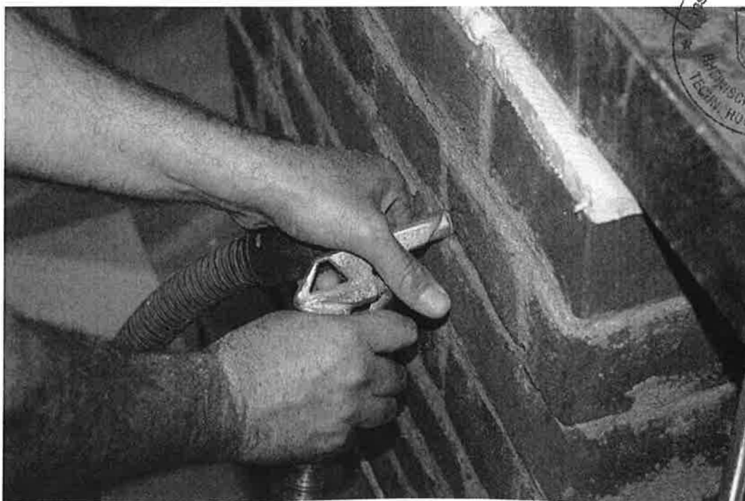
Rys. B2: Wydmuchiwanie pozostałości pyłu wiertniczego sprężonym powietrzem pozbawionym oleju.
