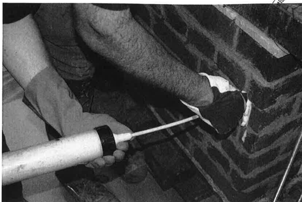
Rys. B3: Wykonywanie iniekcji do próbek przy użyciu ręcznej pompy naboowej
