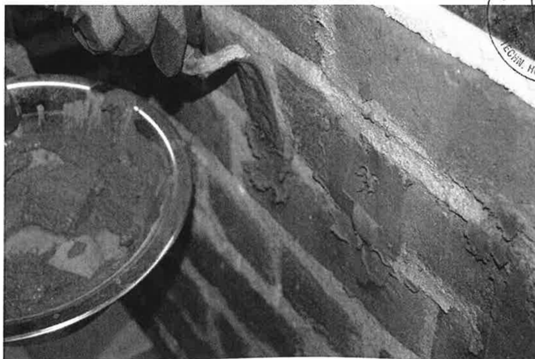
Rys. B4: Uszczelnianie otworów iniekcyjnych szybkowiązącym cementem
