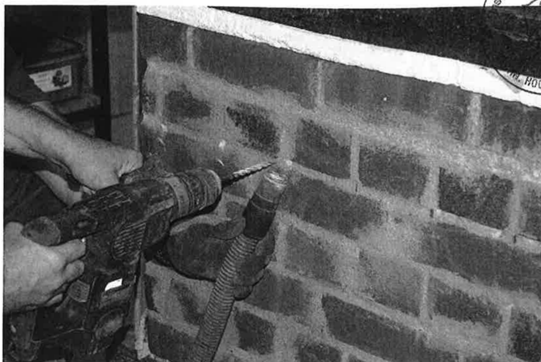
Rys. B1: Wykonywanie otworów prostopadle do usztywnionych w pionie próbek
