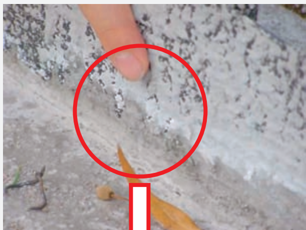
Duxpa-Fugenblech - widoczna krystalizacja
